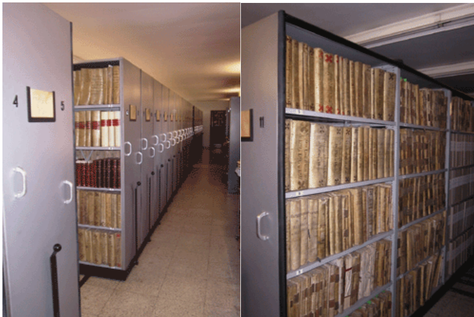
L'ARXIU, de l'any 1969. Sala del Dipòsit. Vista de conjunt i detall de les prestatgeries metàl·liques, de sistema «Compactus». La tècnica constructiva emprada ha permès d'aconseguir per a la documentació uns òptims resultats climàtics, malgrat l'ubicació de l'Arxiu al nucli antic de la ciutat de Barcelona.
