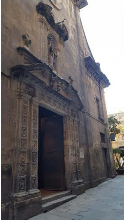
Façana de l'església de sant Sever abans de les obres.
