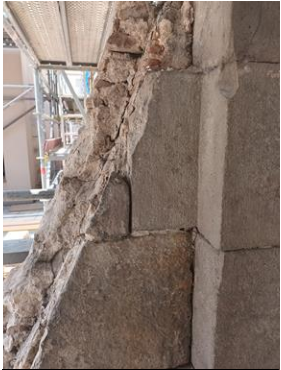
Detall de la façana de l'església de sant Sever.
